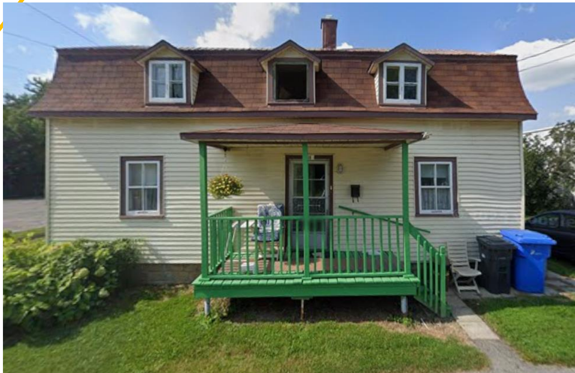
Habitation unifamiliale de structure isolée, construite en 1870.
